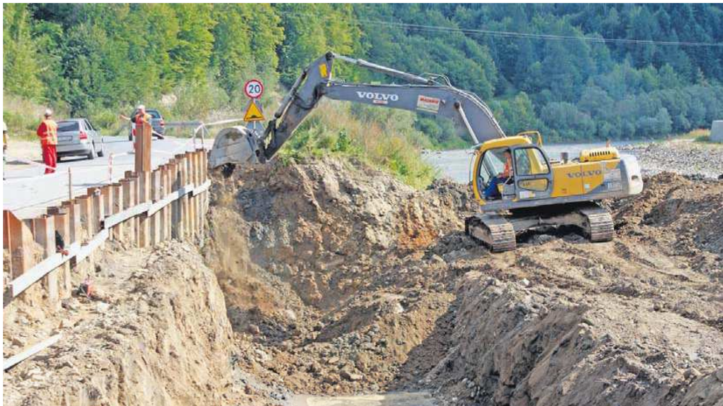
Trwają ostatnie prace na budowie wału przeciwpowodziowego przy ulicy Leśnej w dzielnicy Folwark w Muszynie
