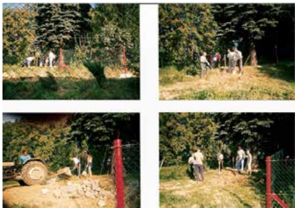
Zdjęcia z budowy kapliczki na osiedlu Wężykówka sierpień 2003 rok (fot. B. Wrońska)
