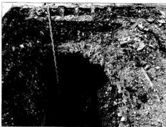
Ulica Dembowskiego w Wieliczce: głęboka dziura w ziemi skrywa wykonany z cegły kanał, który powstał po to, żeby odprowadzić wody Serafy
