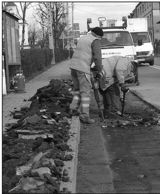
Rozpoczęły się naprawy nawierzchni drogi wojewódzkiej, czyli ul. Imielińskiej. Trzeba liczyć się z utrudnieniami w ruchu.
