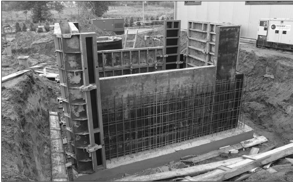
Budowa kanalizacji była w 2009 r. najważniejszą inwestycją miasta. Na zdjęciu fundamenty przepompowni.
