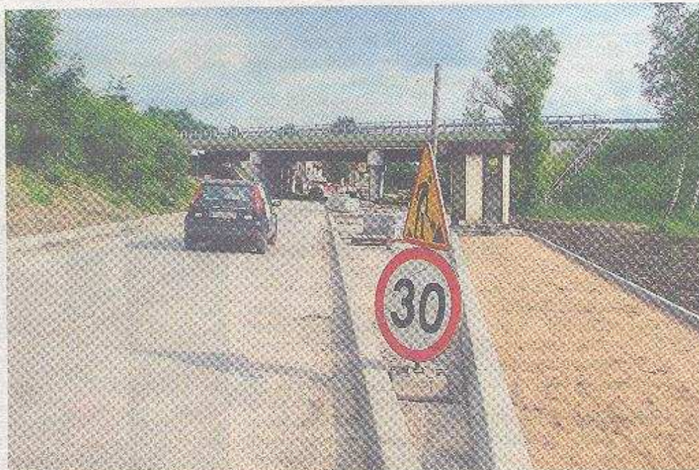
Remont ulicy Fabrycznej w Sławkowie potrwa do września tego roku
